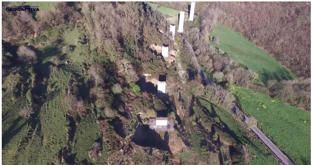
Viaducto sobre el río Nonaya
