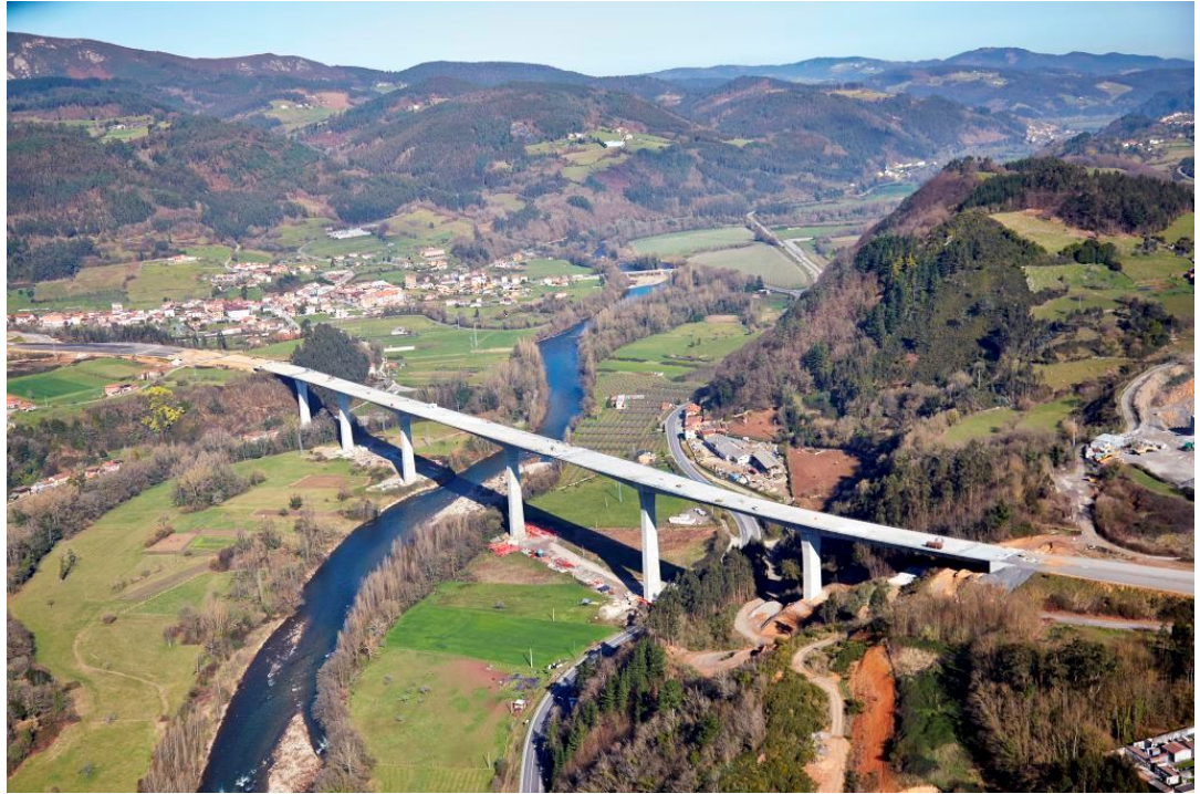
Viaducto sobre el río Narcea
