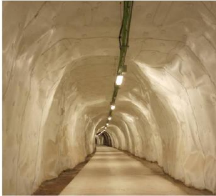
Vista de la sección de la galería
