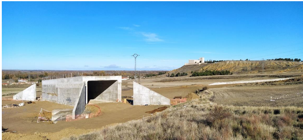
Obras en ejecución en la LAV Palencia-Santander
