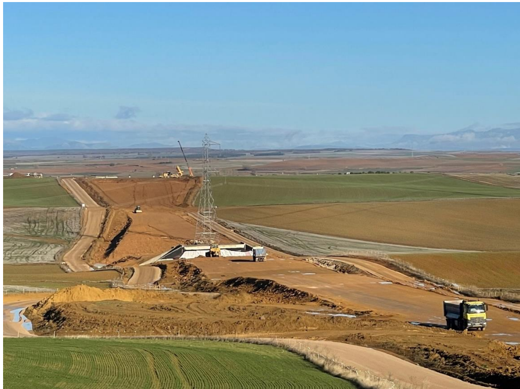
Obras en ejecución en la LAV Palencia-Santander
