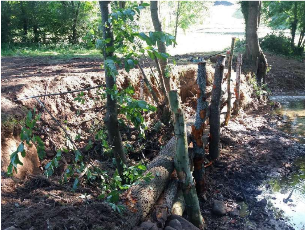
Durante: Técnicas de bioingeniería: construcción de empalizada vegetal
